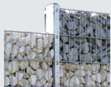
Steinmauer mit feuerverzinkten Pfosten
